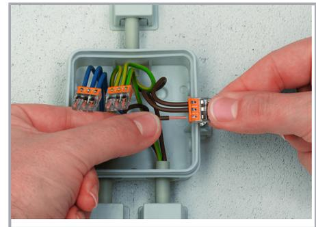
Anschließen: Abisolierten eindräftigen Leiter bis zum Anschlag einstecken.
