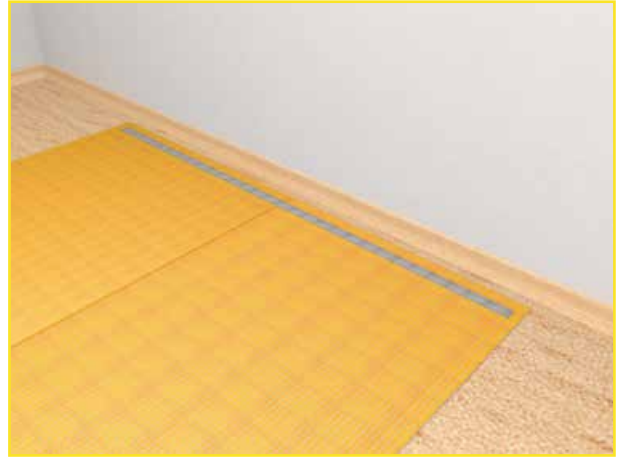
Abb.23: Erdungsband verkleben (nur bei 2 oder mehr Bahnen)
