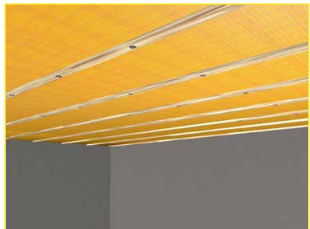
Abb.19: Fixe Befestigung der Bahnen - Entfernen der Hilfsnägel
